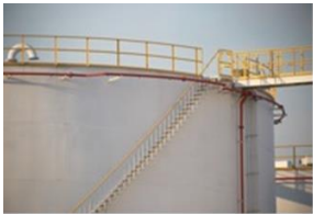
Tratamento de água e esgoto
